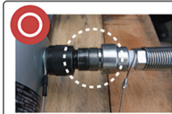
カブラー差込みの良い例 ねじ部分に隙間なし
